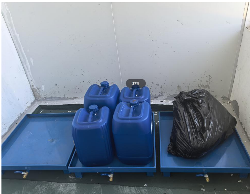
图 3-2 危废间储漏托盘
