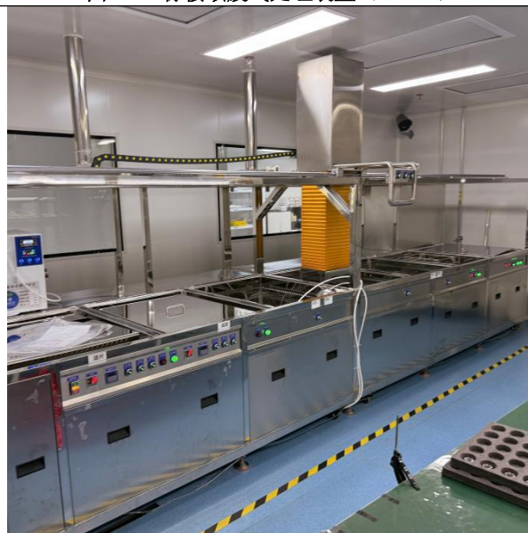
图3-4 清洗设备区 (清洗槽集气罩为旧工艺设计, 实际生产过程不使用)
