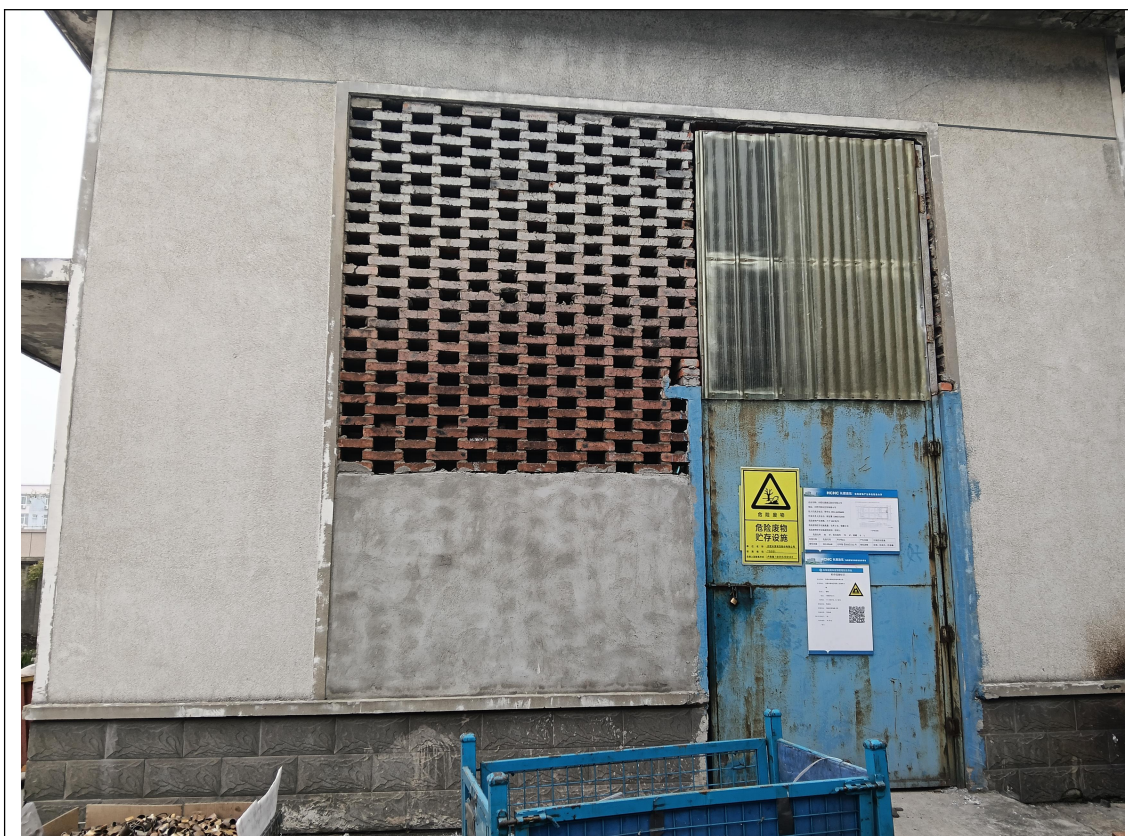
危废暂存库外部
