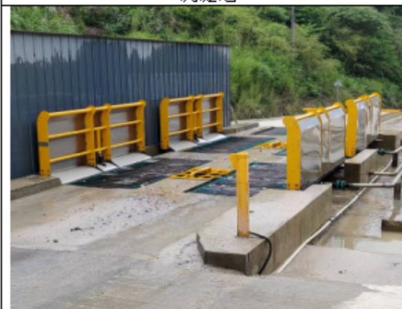
车辆冲洗平台
