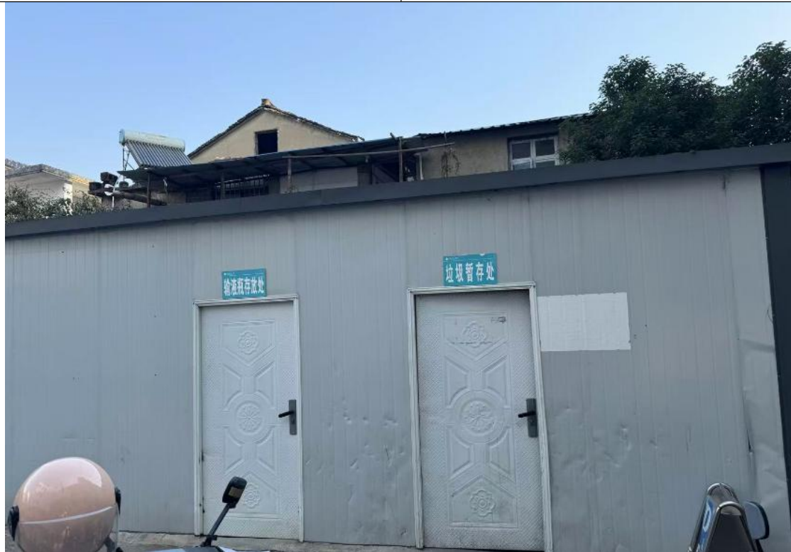
输液瓶、垃圾暂存（一般固废）
