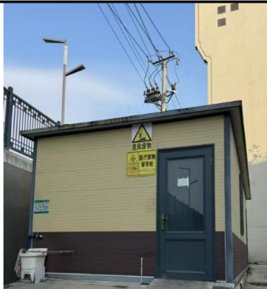
医疗废物暂存间
