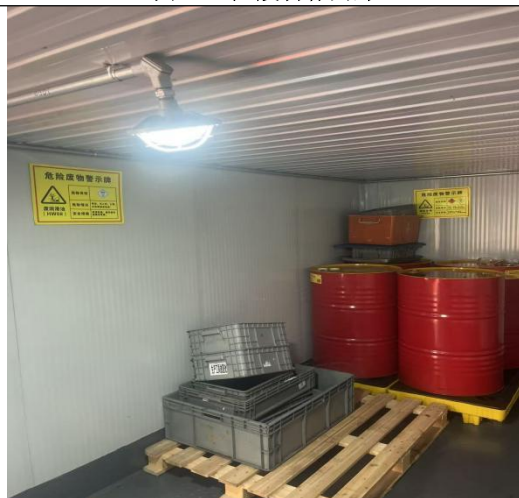
图3-15 危废暂存间内
