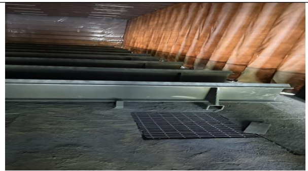
图3-8 “地吸式”废气收集
