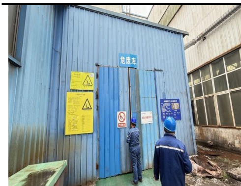
图3-13 危废暂存间外
