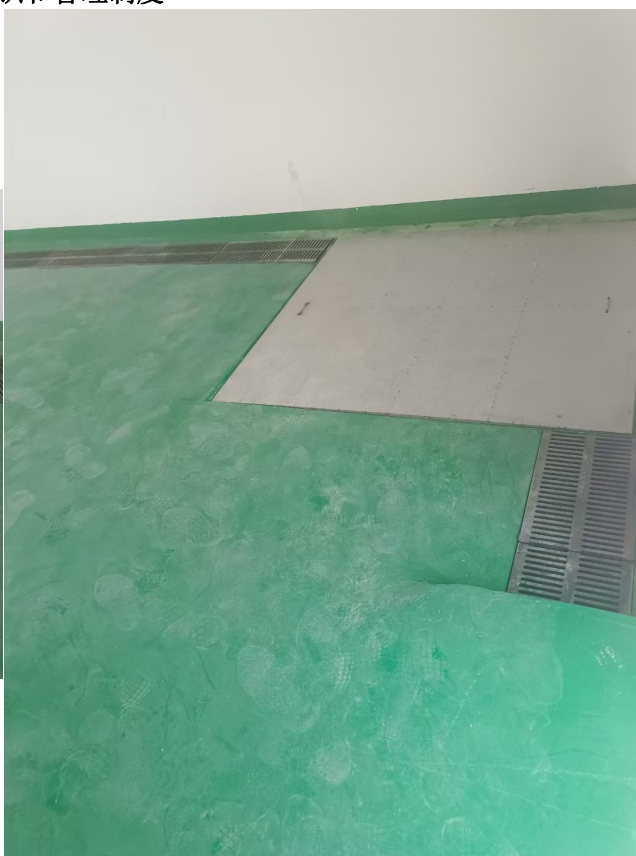
危废暂存间集液井
