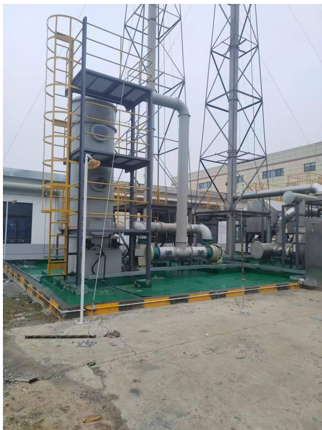
水喷淋系统和 DA007 排气筒（25m）
