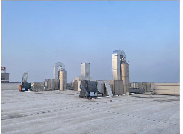
喷漆房废气处理设备（喷淋塔+过滤棉+活性炭吸附装置）
