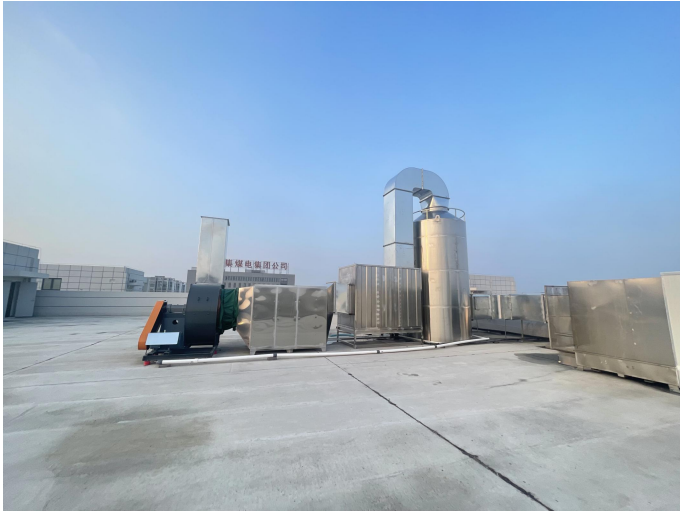
喷漆房废气处理设备（喷淋塔+过滤棉+活性炭吸附装置）
