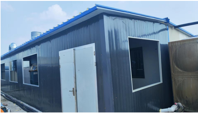
注塑工序废气处理（喷淋塔+活性炭吸附装置+光催化氧化）
