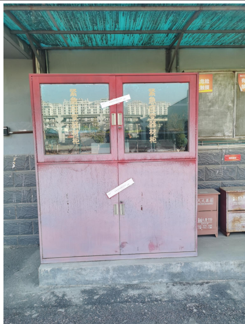
化学品库消防设施
