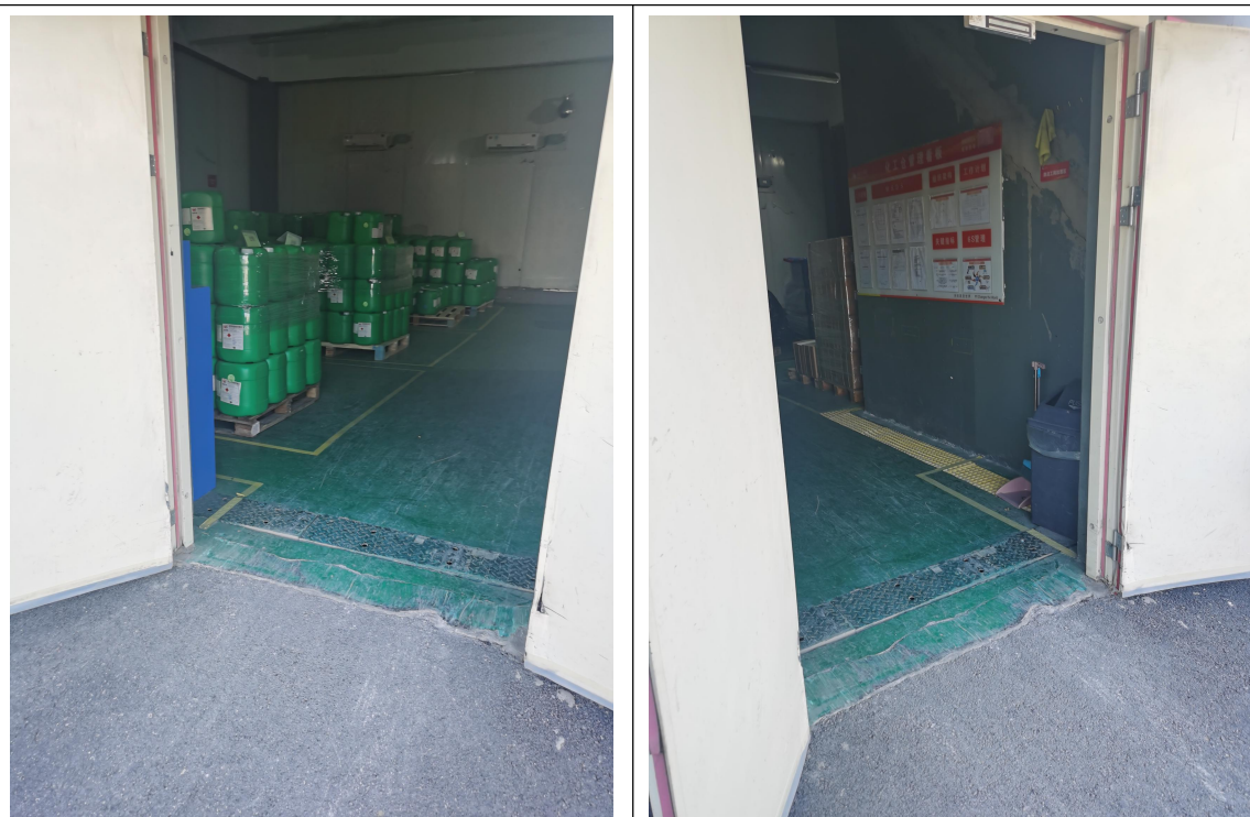
化学品库防腐防渗及导流沟
