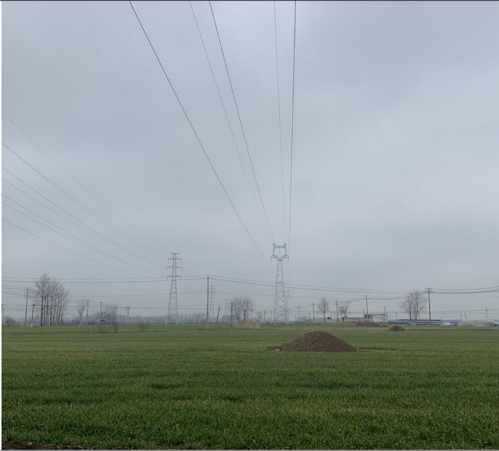
临时占地恢复状况
