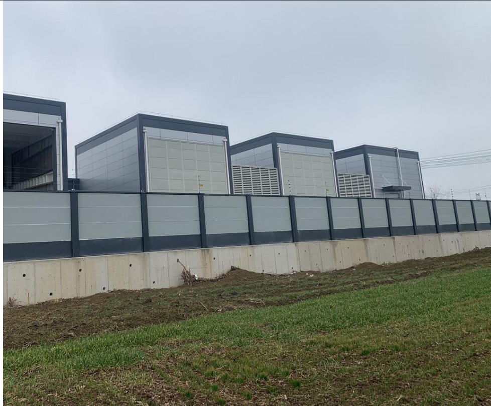
临时占地恢复状况
