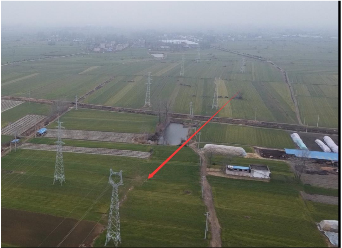
图6-2 本工程航拍图（线路）
