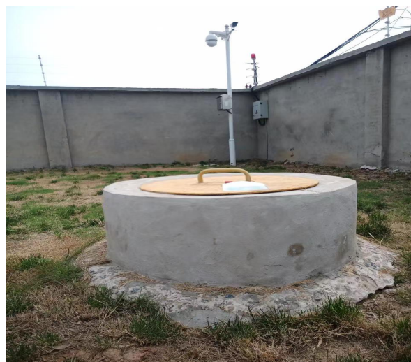
地下水监控井
