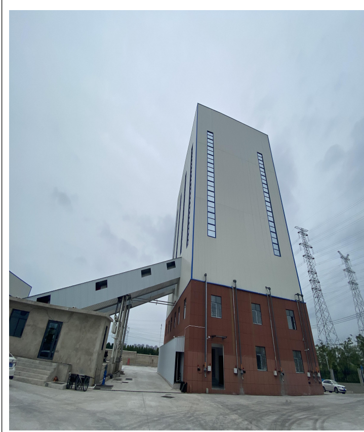
密闭输送物料+搅拌楼
