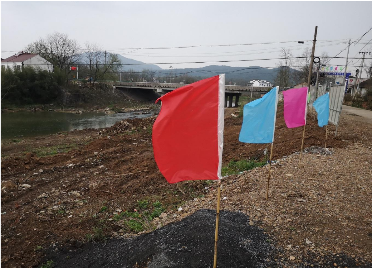
麻元桥-塔里桥段施工前现状
