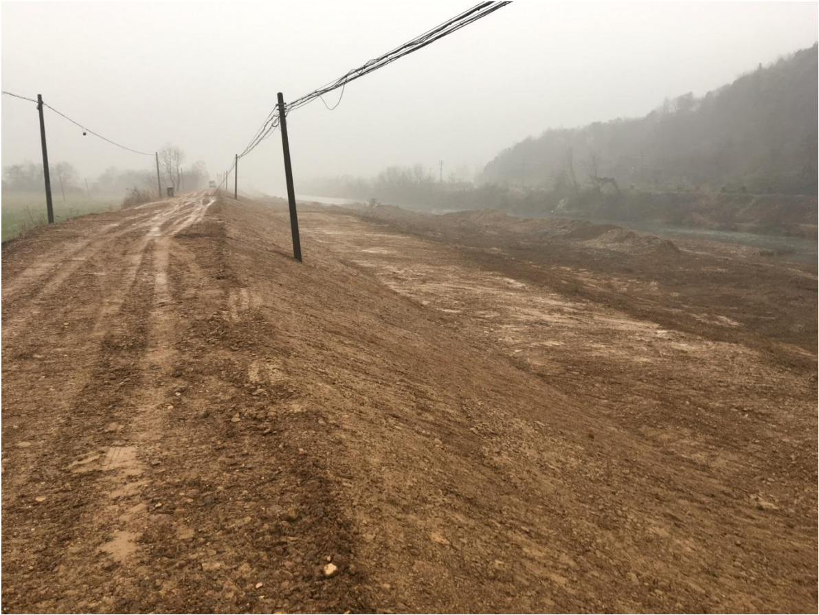
狮子山坝-麻元桥段施工照片
