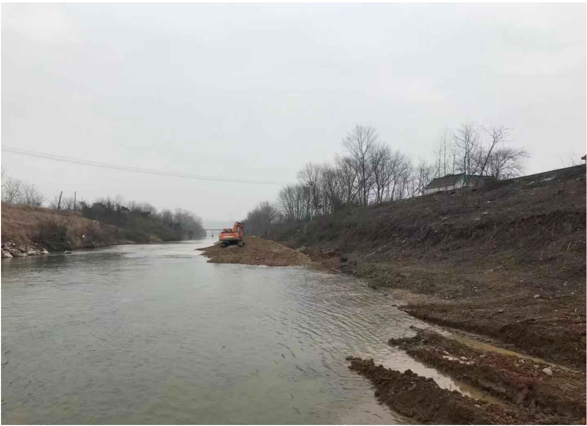
柏山段施工前现状
