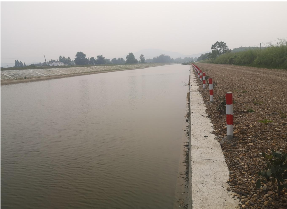
中山坝-南陵坝段改造后现场照片
