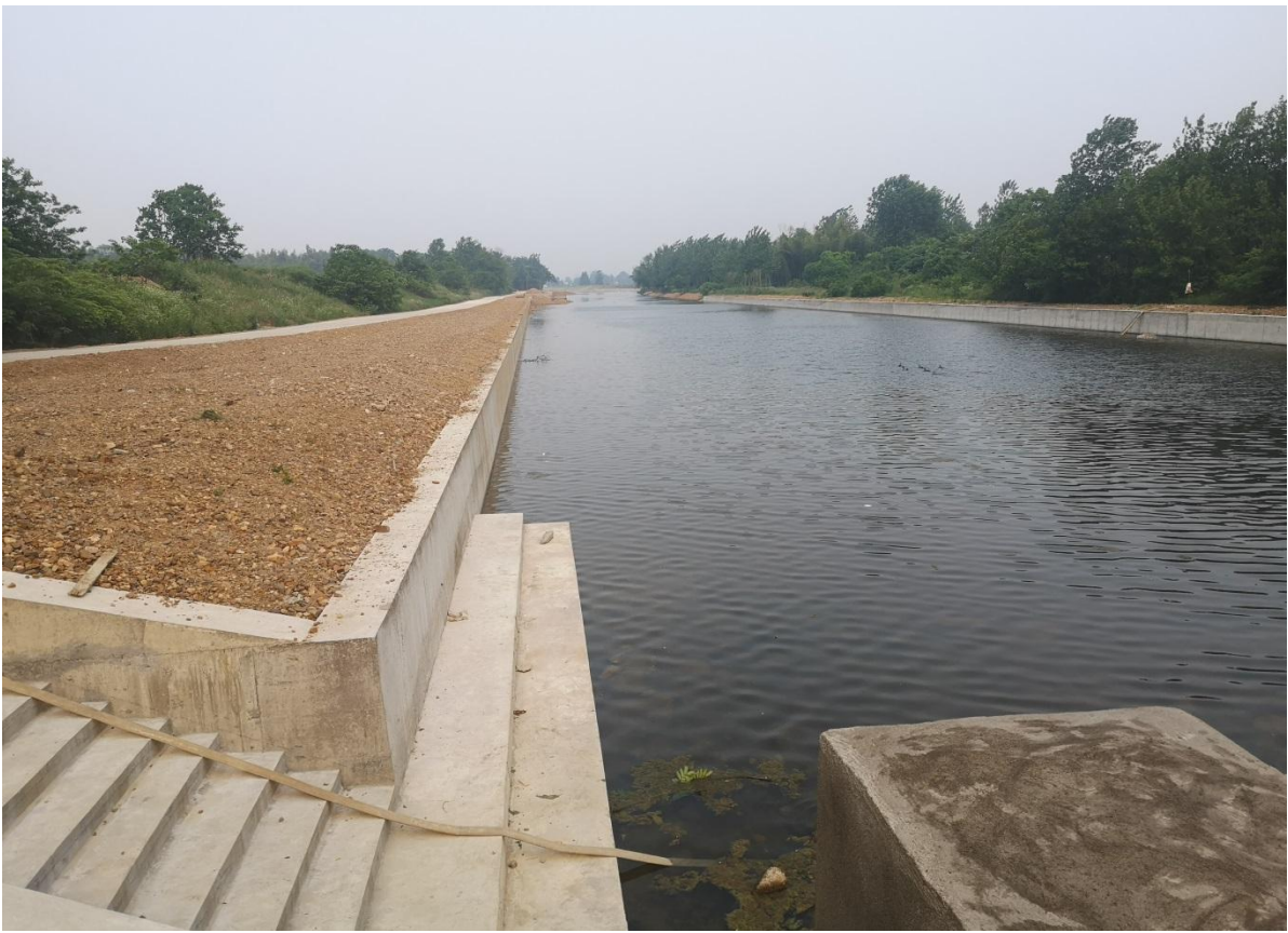
塔里桥至中山坝段改造后现场照片
