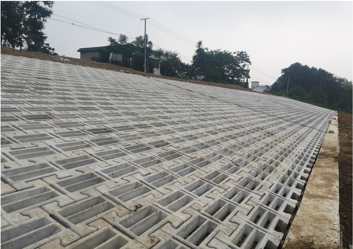
麻元桥-塔里桥段改造后现场照片
