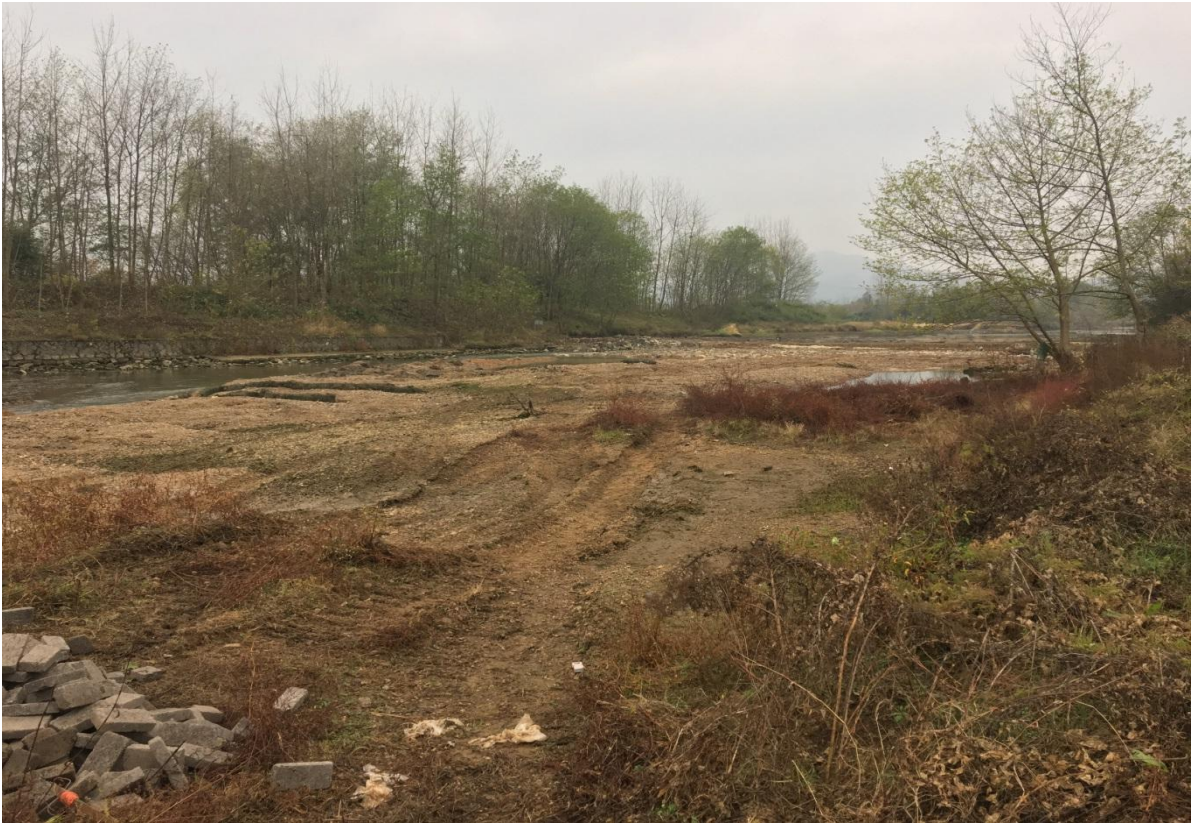
中山坝-南陵坝段施工前现状
