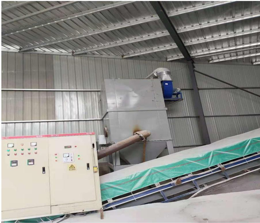
破碎工序除尘设备
