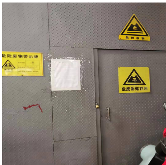
危险废物暂存间
