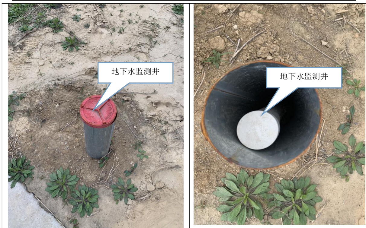
厂区地下水监测井
