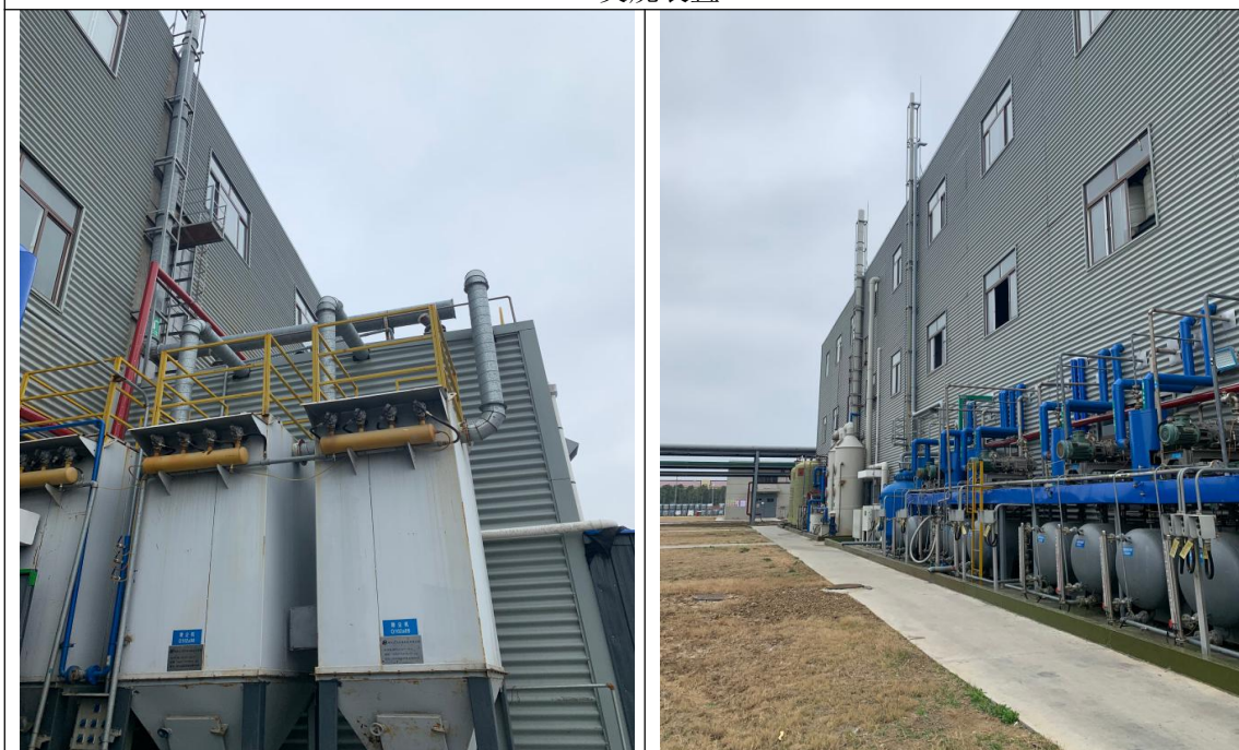
双层填料旋流喷淋塔+双层 NaOH 碱雾吸收塔、二级活性炭吸附装置
