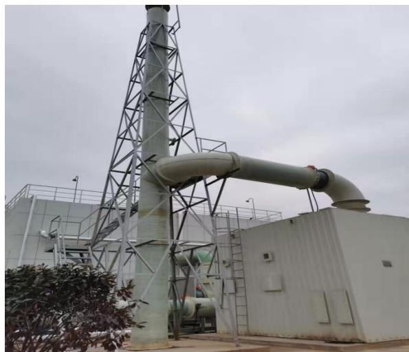
渗滤液处理站活性炭喷射装置
