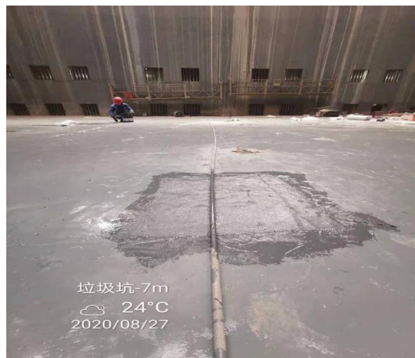
防渗施工照片
