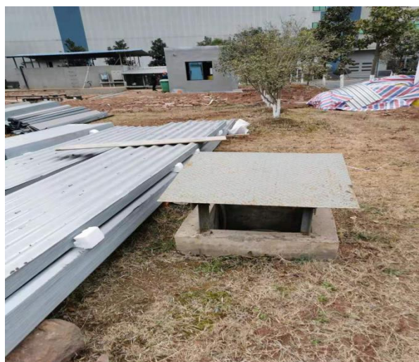
初期雨水收集池
