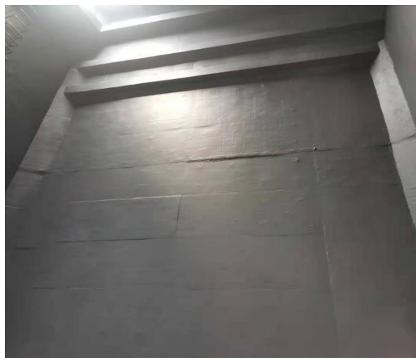
防渗施工照片
