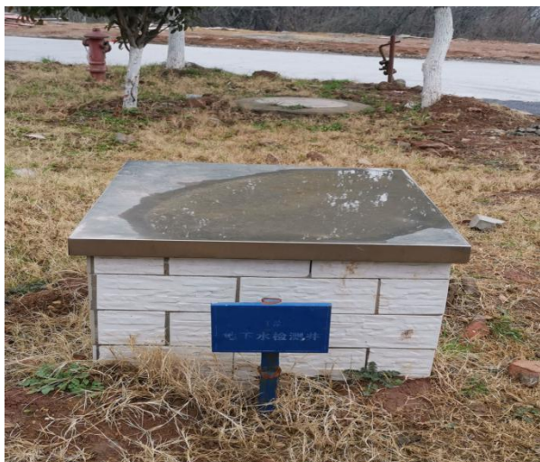
地下水监控井
