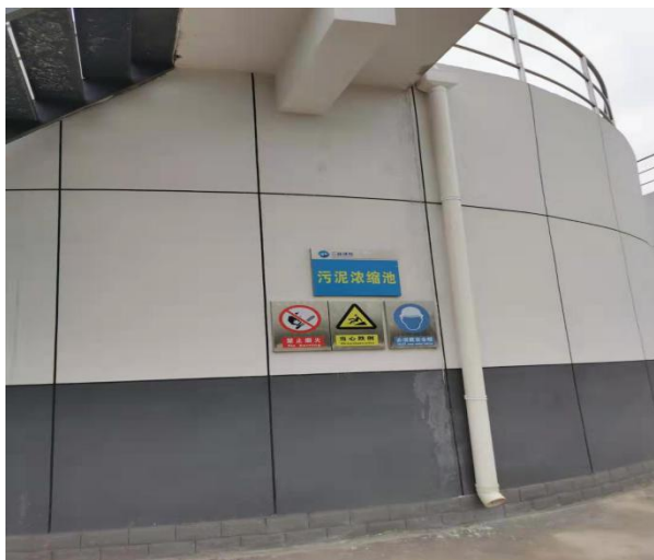
渗滤液处理站污泥浓缩池
