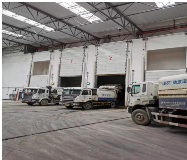
垃圾卸料大厅
