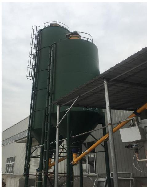
图 3-3 筒仓粉尘：脉冲袋式除尘器+高空排放
