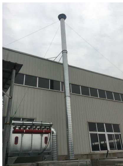
图 3-4 配料仓投料口设置集气罩+1 台布袋除尘器+15m 高排气筒
