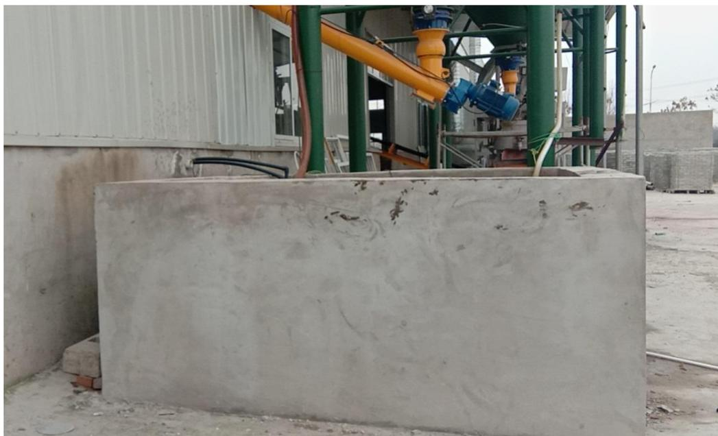
图 3-2 搅拌机清洗废水：搅拌机清洗废水经沉淀池处理
