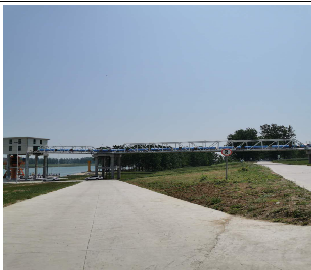
封闭式皮带机输送
