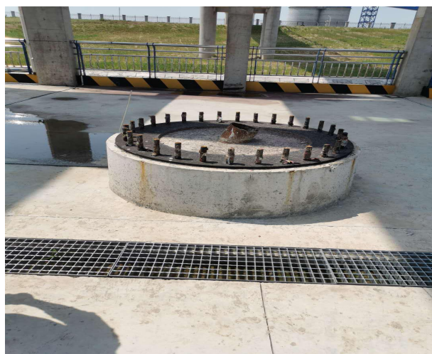
废水收集沟槽
