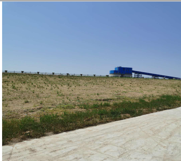
仓顶除尘设施
