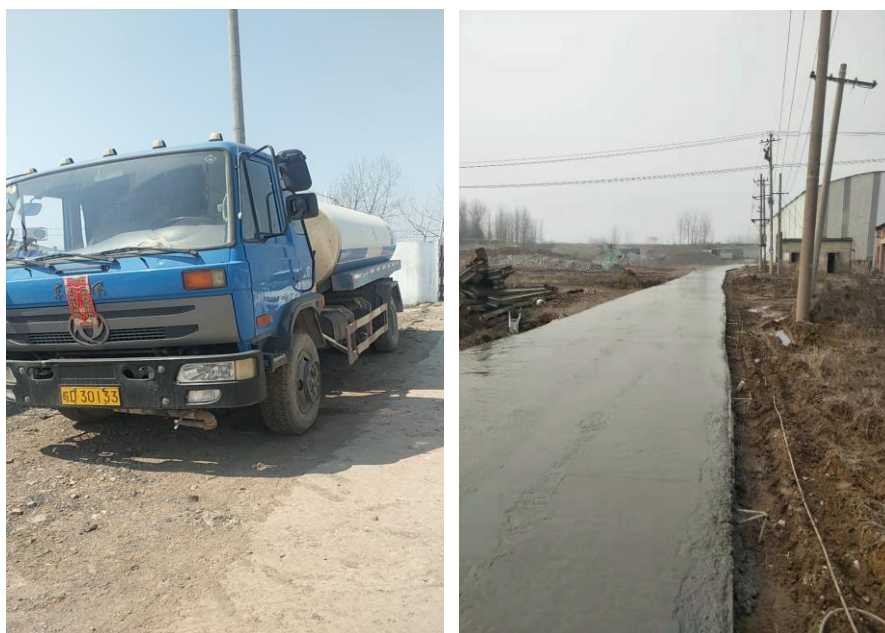
图 3-5 车辆运输道路硬化、洒水车
