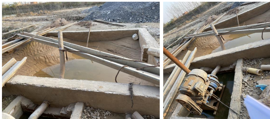
图 3-2 洗砂废水沉淀池
