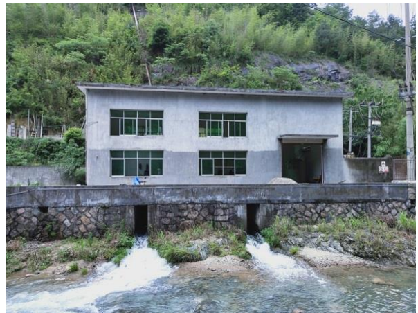
发电厂房及尾水渠
